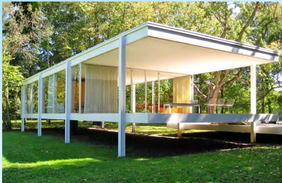
Casa Farnsworth (1951). Diseñada por Mies Van der Rohe a unos 90 km al sur de Chicago en EUA. Tomada de https://www.pinterest.es/pin/124060164713264342/
