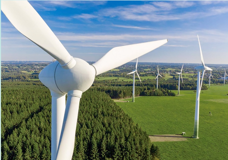
Figura 2. Turbina eólica (AESVAL,2022).
